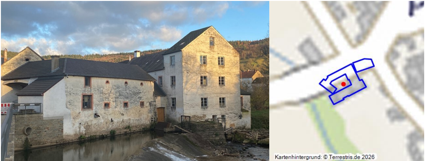
Ehemalige Mühle in Peffingen Fotograf/Urheber: Kreisverwaltung Eifelkreis Bitburg-Prüm, erstellt im Rahmen des Zukunfts-Check Dorf
