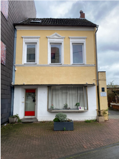
Wohn- und Geschäftshaus der Töpferei Frentz (2023) Fotograf/Urheber: Nicole Schmitz
