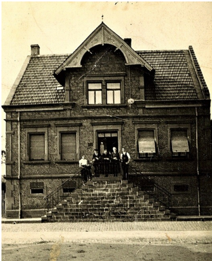
Musikantenhaus in der Friedhofstraße in Mackenbach, erbaut im Jahre 1906 (um 1910) Fotograf/Urheber: unbekannt
