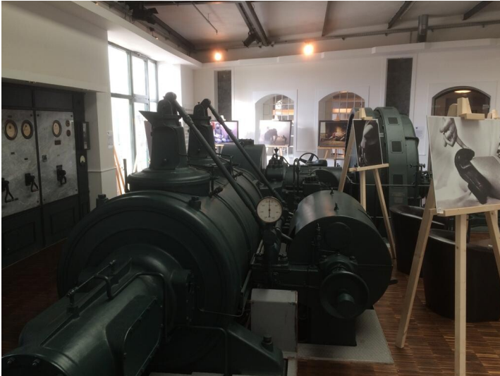
Die Kolbendampfmaschine im Maschinenraum der Rheinberger AG in Pirmasens (2019) Fotograf/Urheber: Peter Felber
