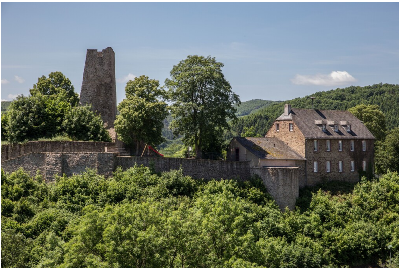
Burgruine Dasburg Fotograf/Urheber: Kreisverwaltung Bitburg-Prüm
