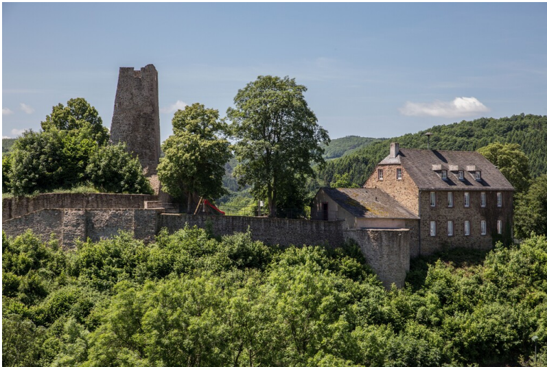
Burgruine Dasburg Fotograf/Urheber: Kreisverwaltung Bitburg-Prüm
