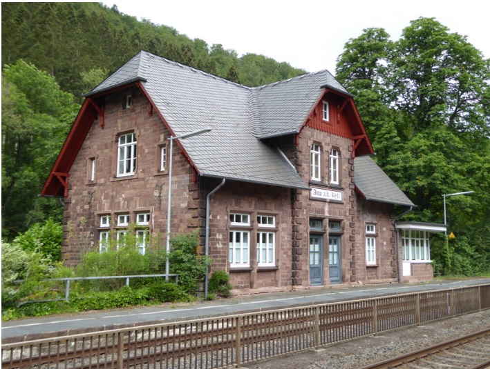
Bahnhof Auw an der Kyll Fotograf/Urheber: Detlef Kleintitschen, Bitburg
