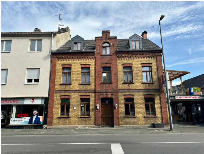
Das Haus Hauptstraße Nr. 388 entstand um 1900. Die zweifarbige Backsteinfassade nimmt mit ihren fünf Achsen viel Raum ein (2023). Fotograf/Urheber: Lisa Kröger
