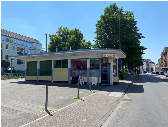
Die ehemalige Wartehalle des Busbahnhofs Porz wurde in den 1950er Jahren errichtet, sie steht unter Denkmalschutz, verfällt jedoch zusehends. Blick auf den Westflügel (2023). Fotograf/Urheber: Lisa Kröger
