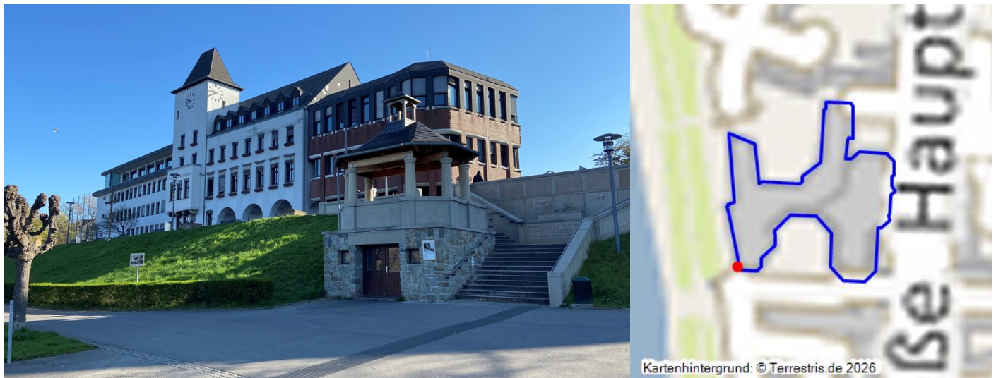
Das Porzer Rathaus vom Rheinufer aus gesehen mit dem Kernbau von 1910 in der Mitte, dem ersten Erweiterungsbau von 1956 links und dem zweiten Erweiterungsbau von 1983 rechts (2023). Fotograf/Urheber: Lisa Kröger
