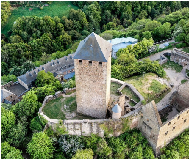
Bergfried der Burg Lichtenberg (2020) Fotograf/Urheber: Sven Grajek
