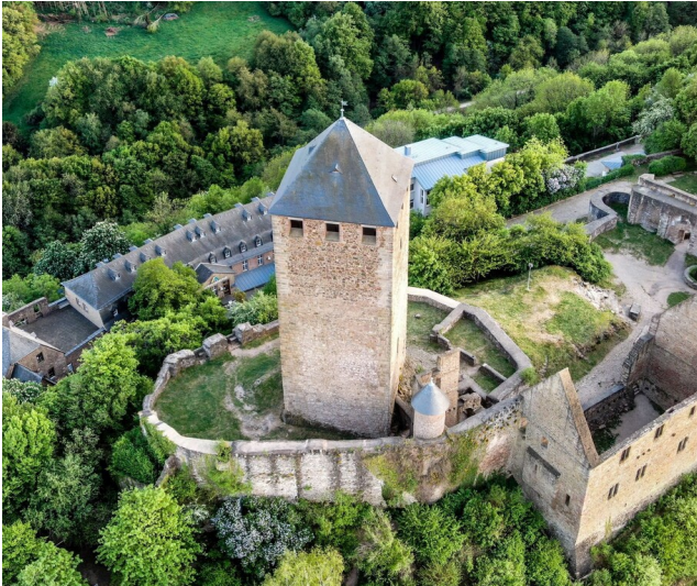
Bergfried der Burg Lichtenberg (2020) Fotograf/Urheber: Sven Grajek
