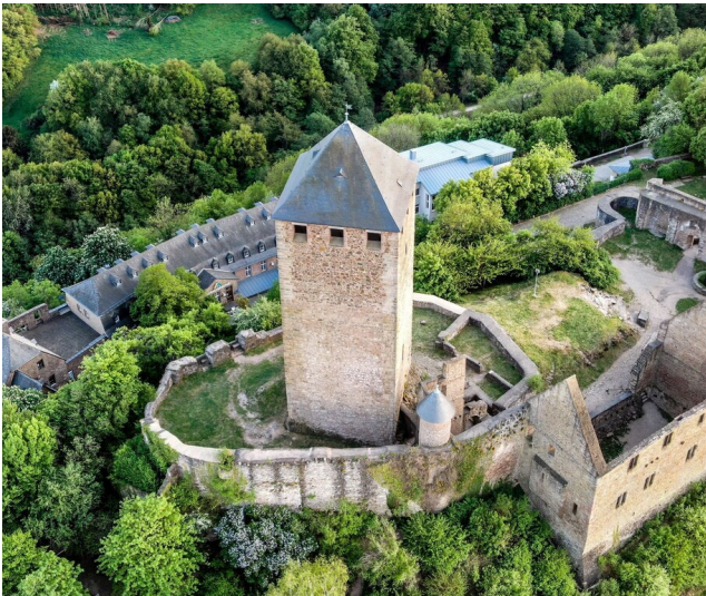
Bergfried der Burg Lichtenberg (2020) Fotograf/Urheber: Sven Grajek
