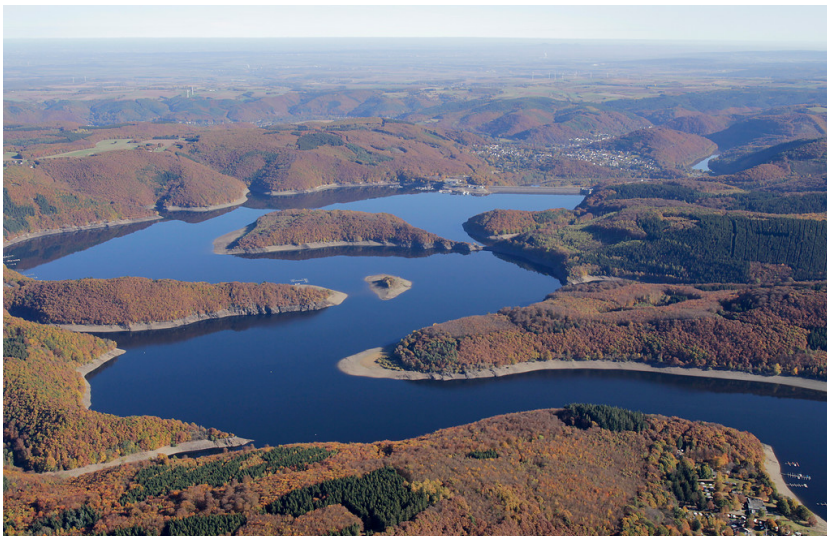
Rurtalsperre (2016) Fotograf/Urheber: Andreas Schmickler
