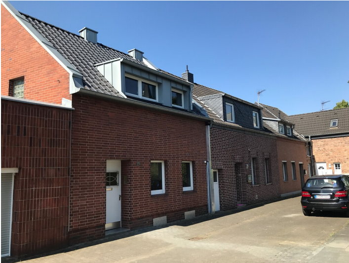
Arbeiterwohnhausreihe in der Hochstedenstraße (2022) Fotograf/Urheber: Nicole Schmitz
