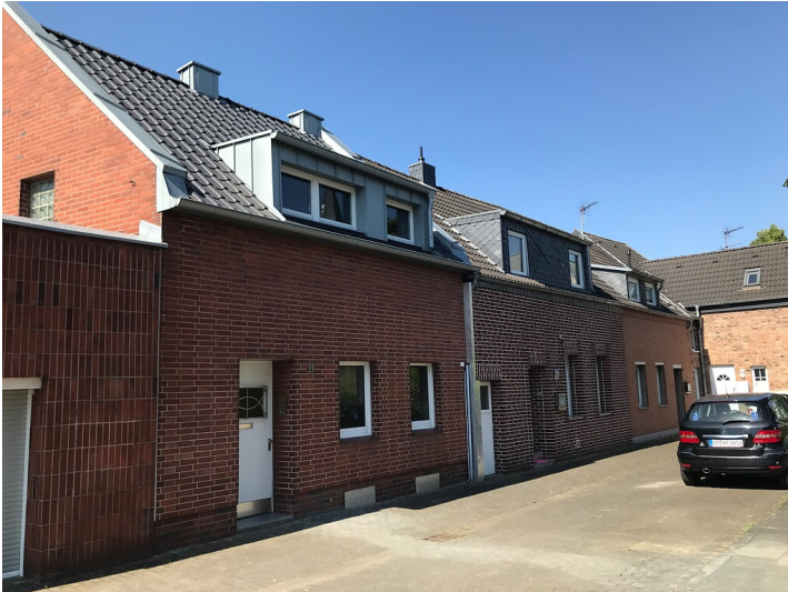
Arbeiterwohnhausreihe in der Hochstedenstraße (2022) Fotograf/Urheber: Nicole Schmitz
