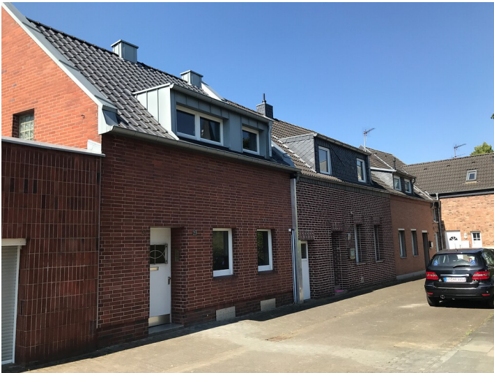
Arbeiterwohnhausreihe in der Hochstedenstraße (2022) Fotograf/Urheber: Nicole Schmitz
