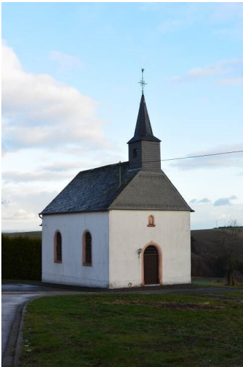
Filialkirche St. Donatus in Muxerath Fotograf/Urheber: Kreisverwaltung Bitburg-Prüm
