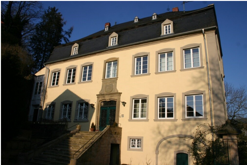
Herrenhaus Fotograf/Urheber: Kreisverwaltung Bitburg-Prüm
