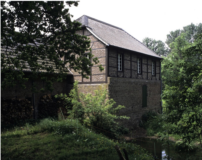
Auf einem Backsteinsockel erhebt sich das Fachwerkgebäude mit Backsteinausfachungen (2008). Fotograf/Urheber: Silvia Margrit Wolf
