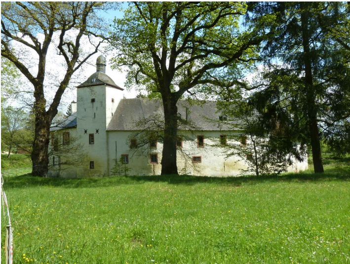
Burg Seinsfeld Fotograf/Urheber: Kreisverwaltung Bitburg-Prüm
