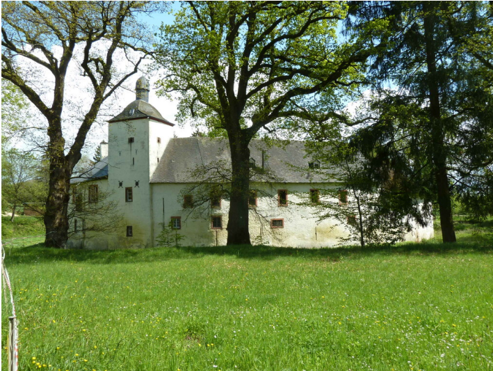
Burg Seinsfeld Fotograf/Urheber: Kreisverwaltung Bitburg-Prüm
