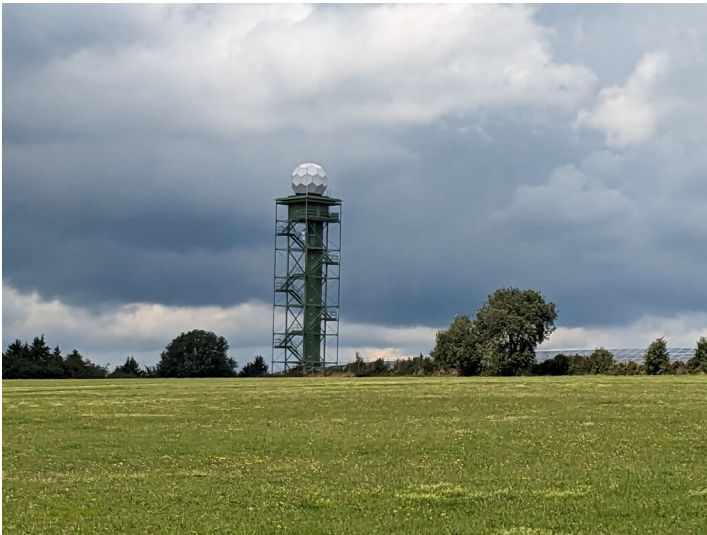
Weterradarstation Neuheilenbach Fotograf/Urheber: Katarina Gerlach
