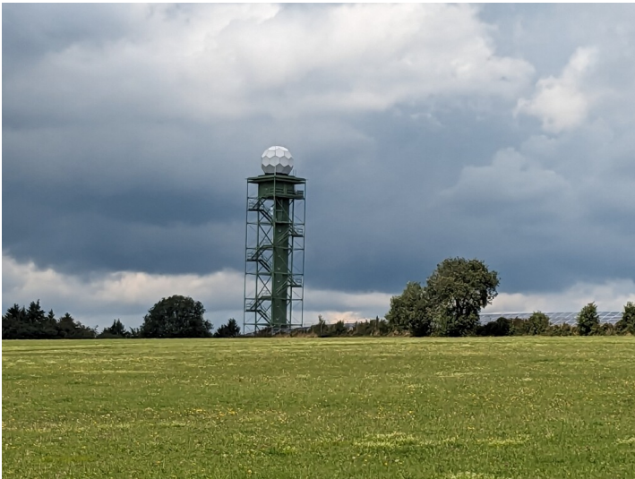
Weterradarstation Neuheilenbach Fotograf/Urheber: Katarina Gerlach
