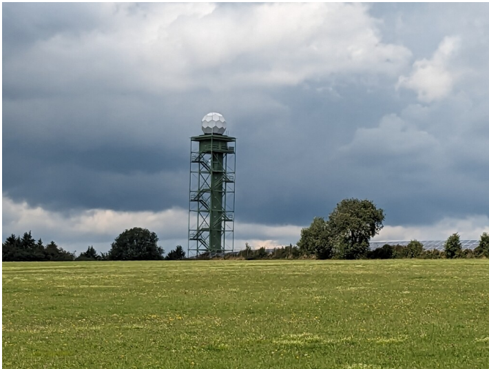
Weterradarstation Neuheilenbach Fotograf/Urheber: Katarina Gerlach
