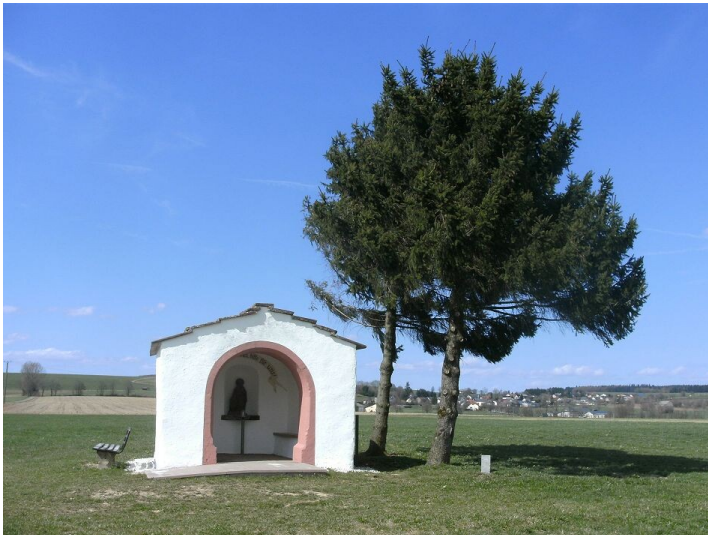
Markuskapelle in Steinborn Fotograf/Urheber: Kreisverwaltung Bitburg-Prüm
