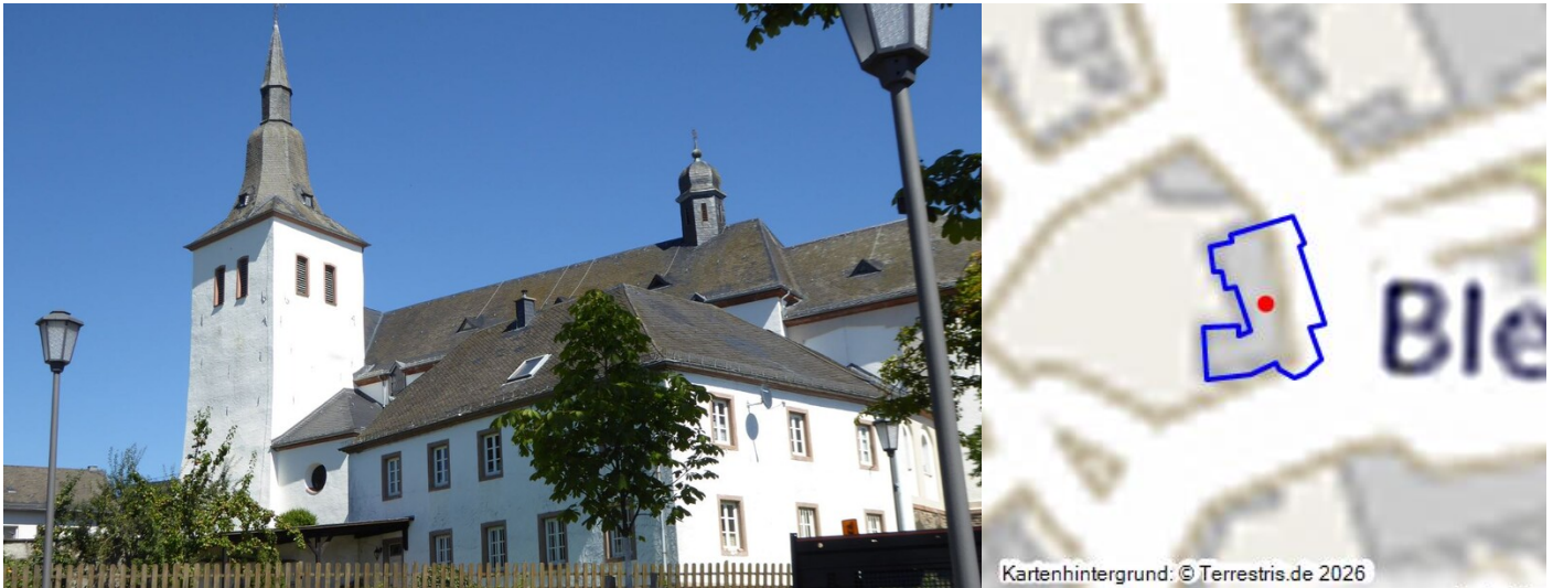
Pfarrkirche Mariä Himmelfahrt in Bleialf Fotograf/Urheber: Kreisverwaltung Bitburg-Prüm
