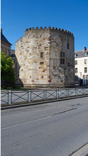
Tour aux Puces (Flohturm) in Thionville, Frankreich (2023) Fotograf/Urheber: Karl Peter Wiemer
