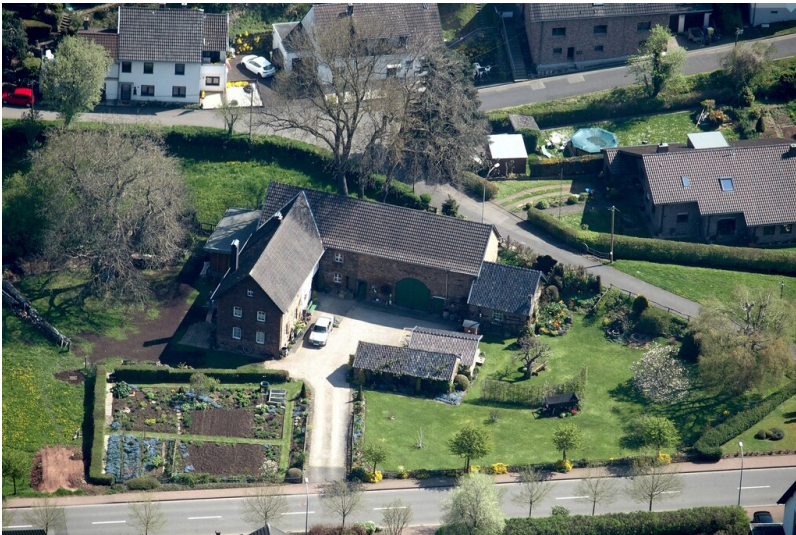
Mühle Falkenstein am Veybach in Eiserfey (2021) Fotograf/Urheber: Karl Peter Wiemer
