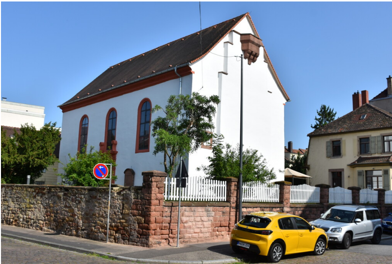
Ansicht der Kirche von Nordwesten Fotograf/Urheber: Dr. Johannes Weingart
