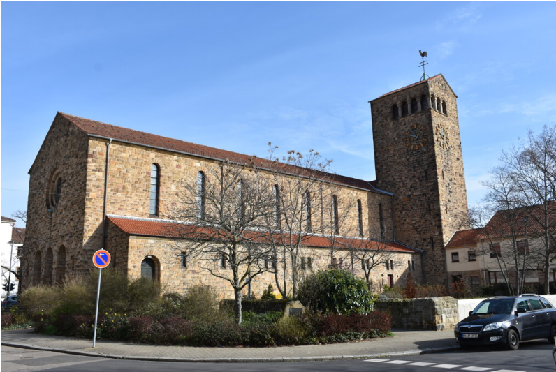
Ansicht der Kirche von Südwesten Fotograf/Urheber: Dr. Johannes Weingart
