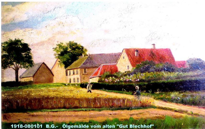
Ölgemälde Blechhof (1918) Fotograf/Urheber: Unbekannt
