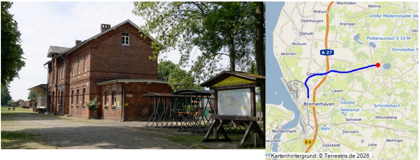
Bahnhof Bederkesa, Empfangsgebäude, Straßenseite (2018) Fotograf/Urheber: Ra Boe
