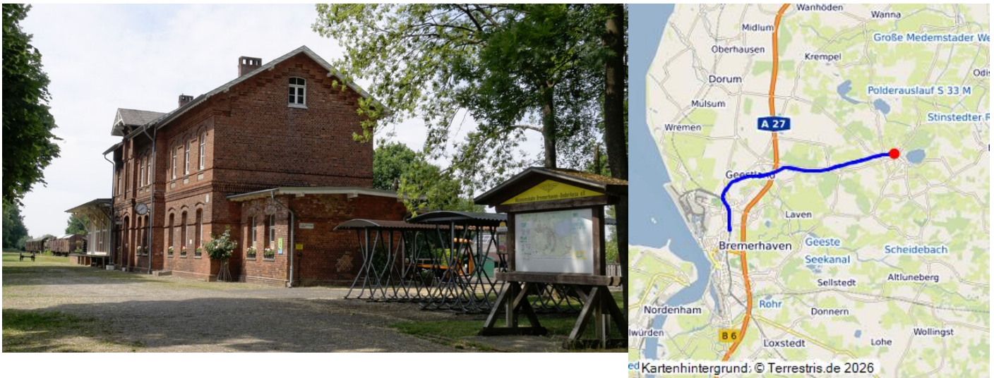
Bahnhof Bederkesa, Empfangsgebäude, Straßenseite (2018) Fotograf/Urheber: Ra Boe
