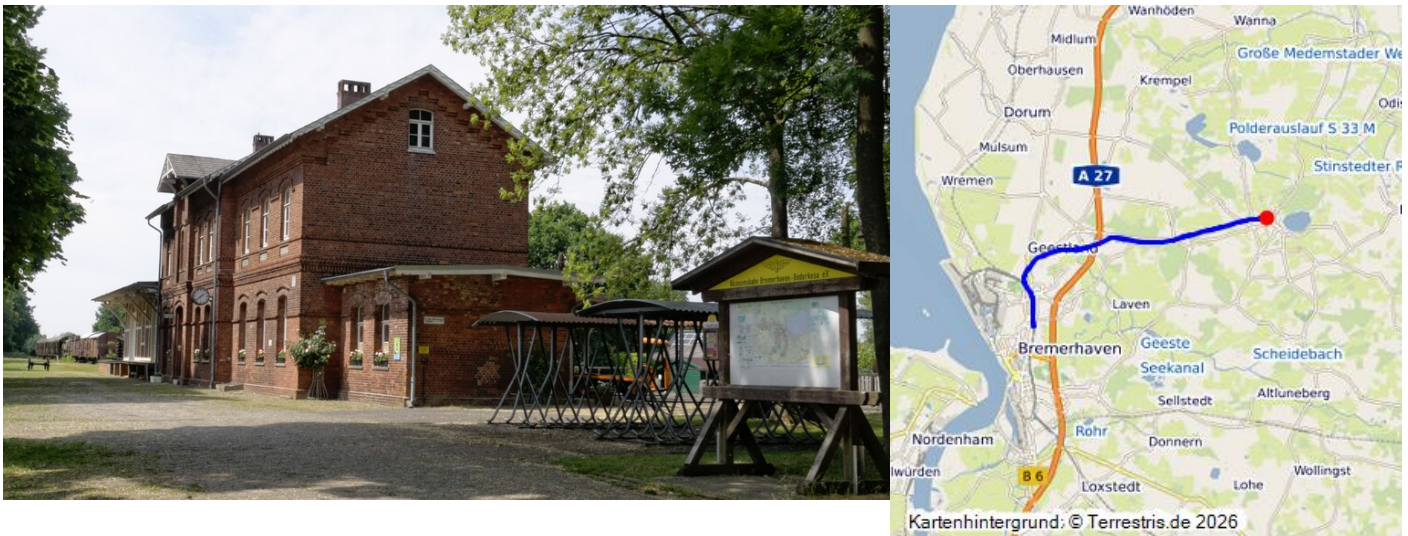
Bahnhof Bederkesa, Empfangsgebäude, Straßenseite (2018) Fotograf/Urheber: Ra Boe
