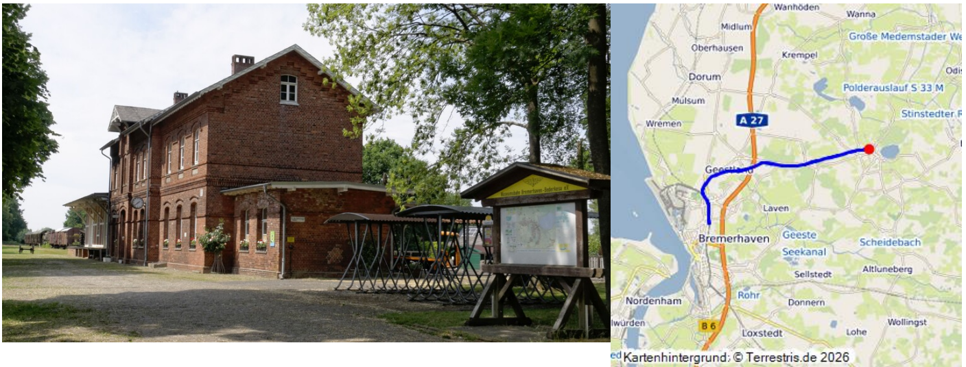
Bahnhof Bederkesa, Empfangsgebäude, Straßenseite (2018) Fotograf/Urheber: Ra Boe
