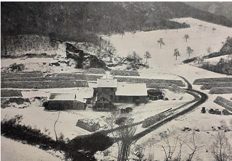
Zervas-Mühle am Brohbach in Brohl-Lützing Fotograf/Urheber: unbekannt
