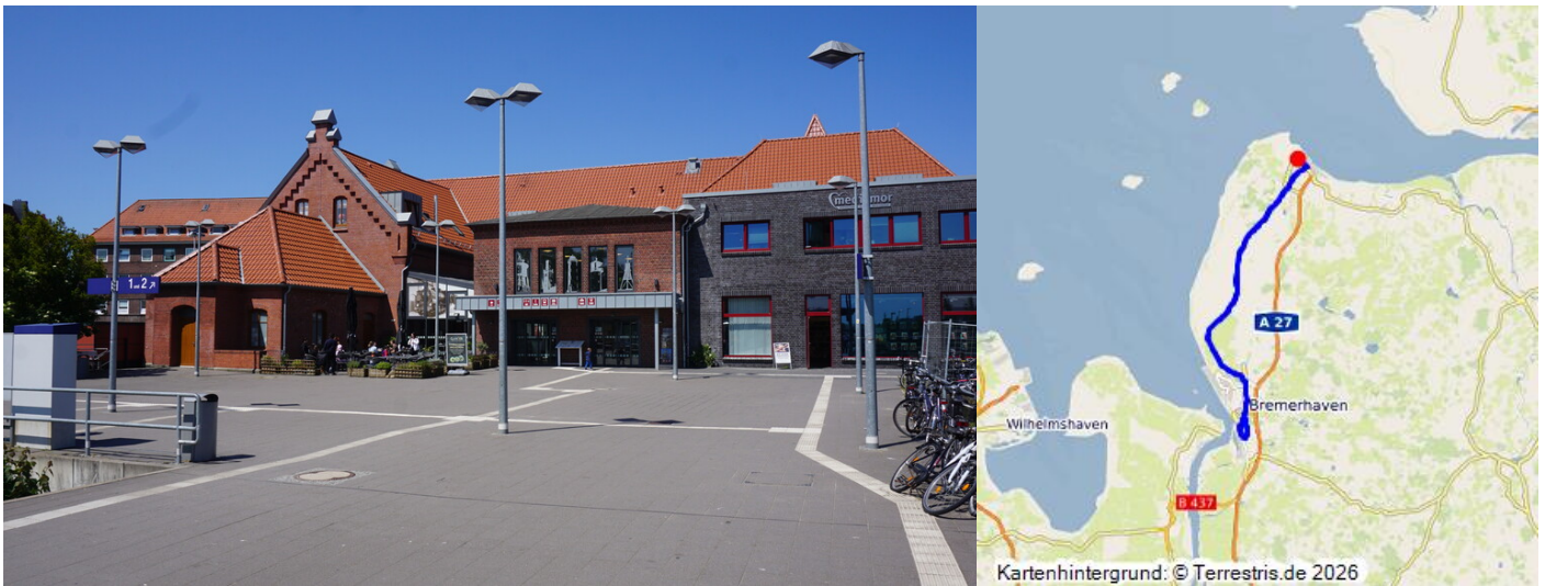
Cuxhaven, Bürgerbahnhof Gleisseite (2023) Fotograf/Urheber: Claus Weber
