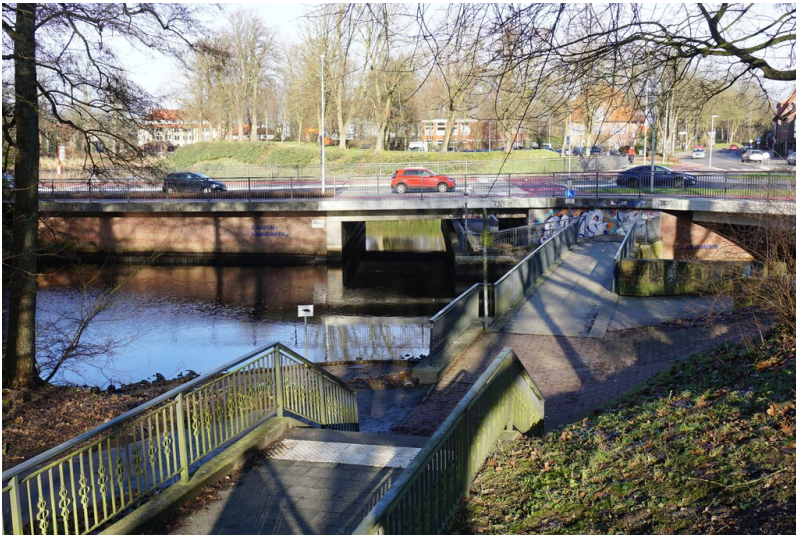
Stade, Schiffertorsbrücke, im Hintergrund Georg-Bastion (2024) Fotograf/Urheber: Claus Weber
