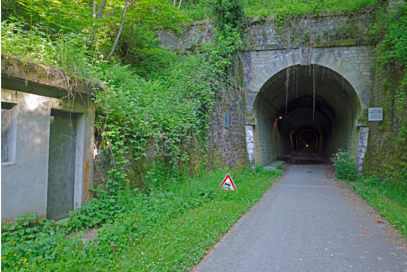
Tunnel Hobscheid (2023) Fotograf/Urheber: Karl Peter Wiemer
