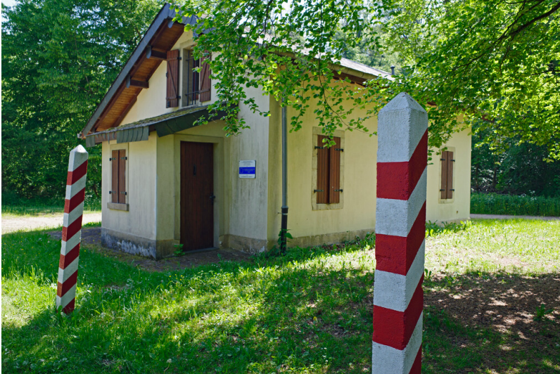
Ehemaliges Bahnwärterhaus bei Grass (2023) Fotograf/Urheber: Karl Peter Wiemer
