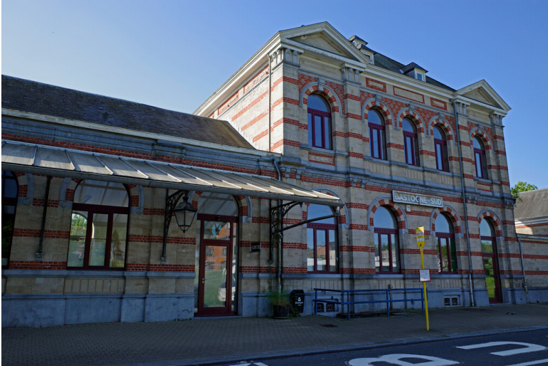
Ehemaliger Bahnhof Bastogne-Sud (2023) Fotograf/Urheber: Karl Peter Wiemer
