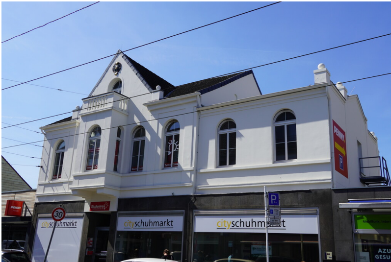
Wohnhaus und Brotfabrik von C. Hauses + Co. in Krefeld-Fischeln (2023) Fotograf/Urheber: Lisa Kröger
