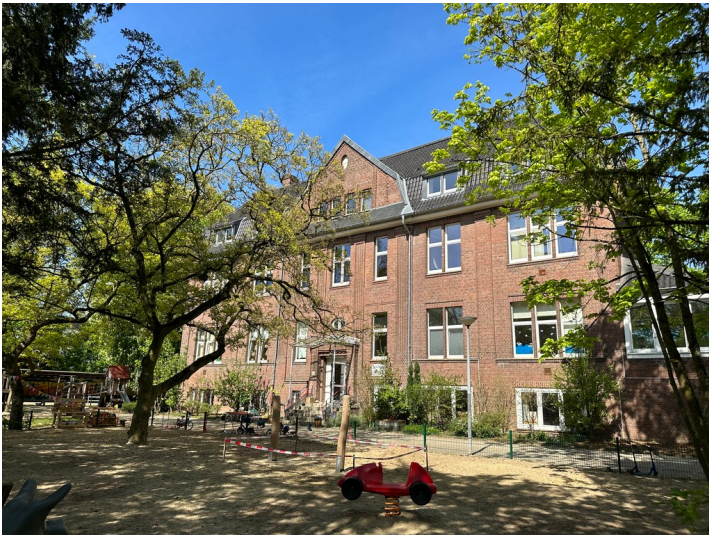
Ehemaliges Krankenhaus in Krefeld-Fischeln (2023) Fotograf/Urheber: Ines Müller
