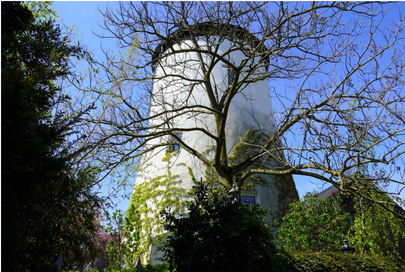
Ehemalige Windmühle in Krefeld-Fischeln (2023). Fotograf/Urheber: Kröger, Lisa
