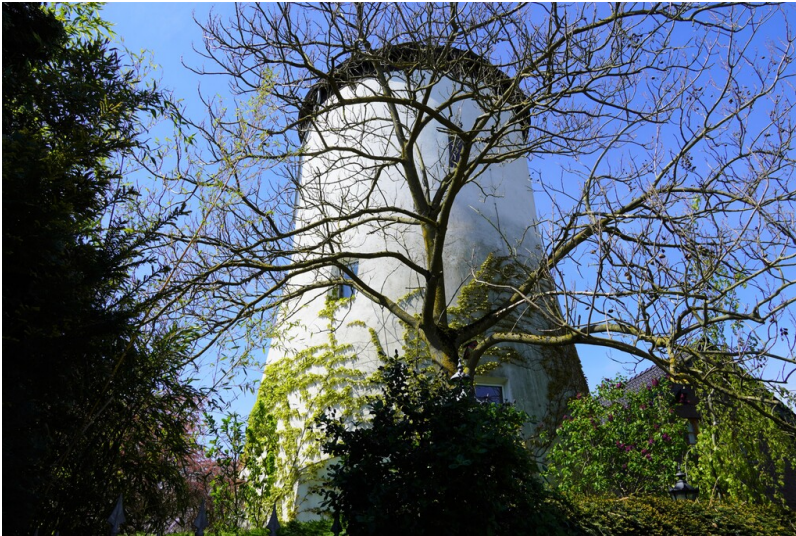
Ehemalige Windmühle in Krefeld-Fischeln (2023). Fotograf/Urheber: Kröger, Lisa
