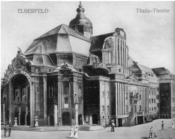
Thalia-Theater in Wuppertal 1906 Fotograf/Urheber: Unbekannt
