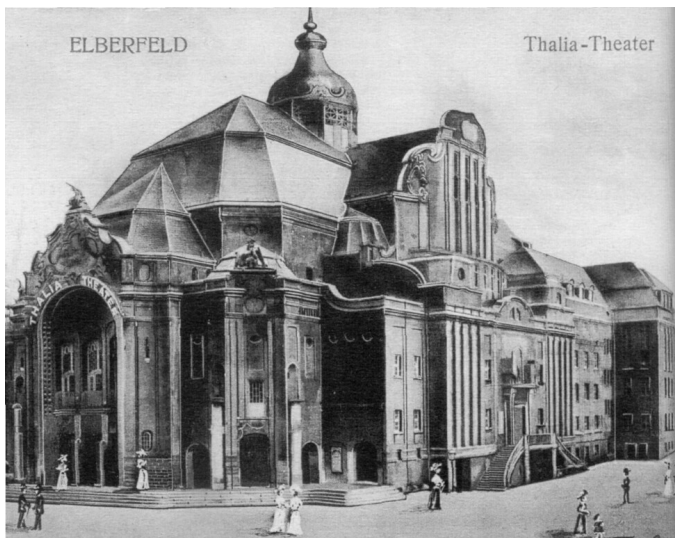
Thalia-Theater in Wuppertal 1906 Fotograf/Urheber: Unbekannt
