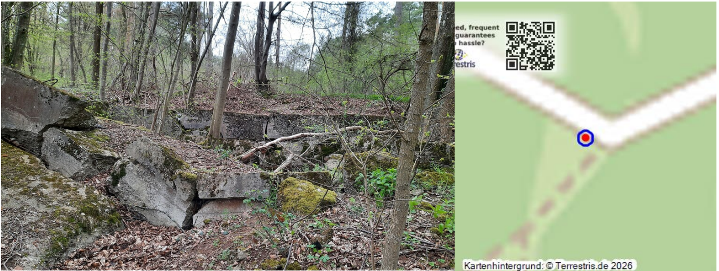
Munitionsbunker am Stockert (2023) Fotograf/Urheber: Martina Gelhar
