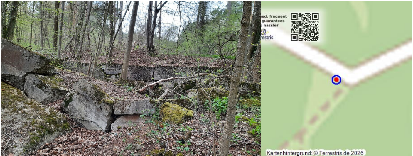
Munitionsbunker am Stockert (2023) Fotograf/Urheber: Martina Gelhar
