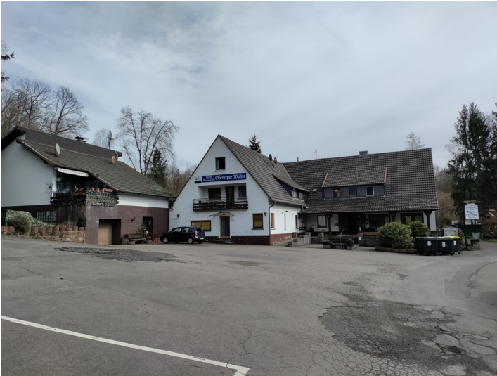
Frontansicht von Westen auf den Gebäudekomplex an der ehemaligen Obereiper Mühle (2023) Fotograf/Urheber: Julia König
