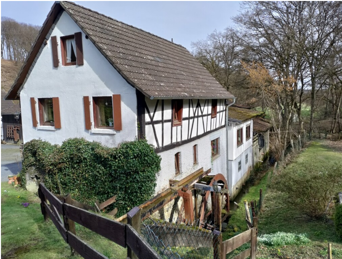
Ravensteiner Mühle: Rückwärtige Ansicht des Mühlengebäudes mit ober-schlächtigem Wasserrad. (2023) Fotograf/Urheber: Julia König
