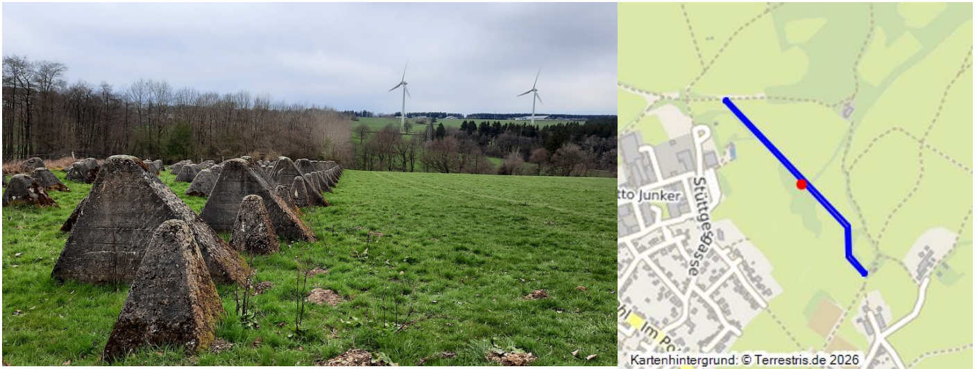
Höckerlinie östlich von Lammersdorf (2023) Fotograf/Urheber: Martina Gelhar
