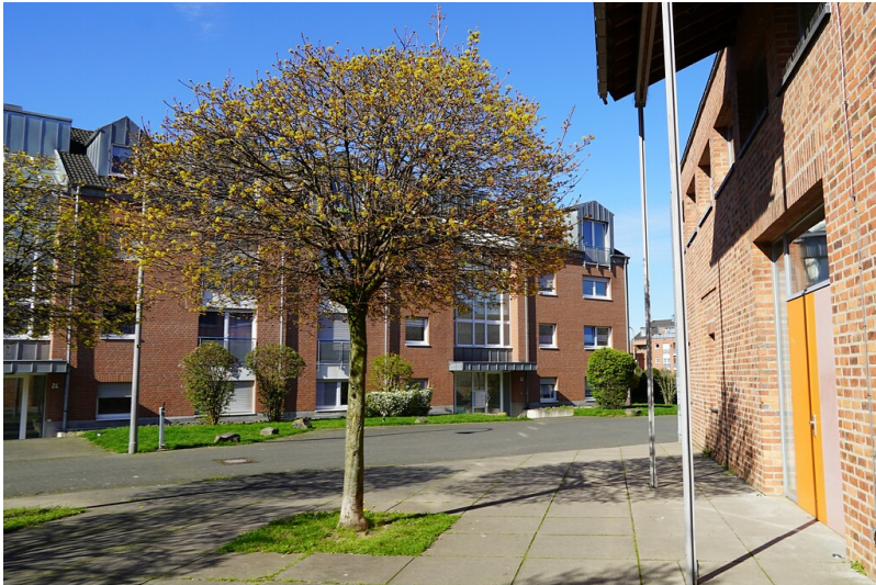
Wohnbebauung an der Döbrabergstraße im Kölner Stadtteil Blumenberg (2023). Fotograf/Urheber: Lisa Kröger
