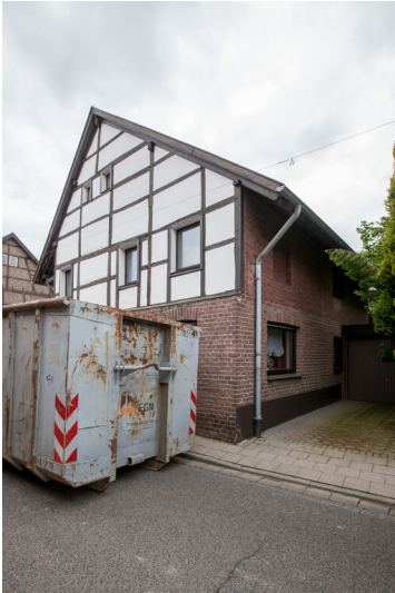
Wohnhaus mit Nebengebäuden - Holzweilerstraße 38 in Erkelenz-Keyenberg (2019) Fotograf/Urheber: Anja Schmid-Engbrodt
