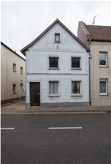
Wohnhaus mit Anbau Borschemicher Straße 21 in Erkelenz-Keyenberg (2019) Fotograf/Urheber: Anja Schmid-Engbrodt
