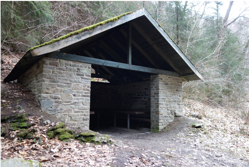
Schutzhütte für Wanderer mit Wänden aus Bruchstein am Standort einer ehemaligen Fischerhütte (2021). Fotograf/Urheber: Martina Gelhar
