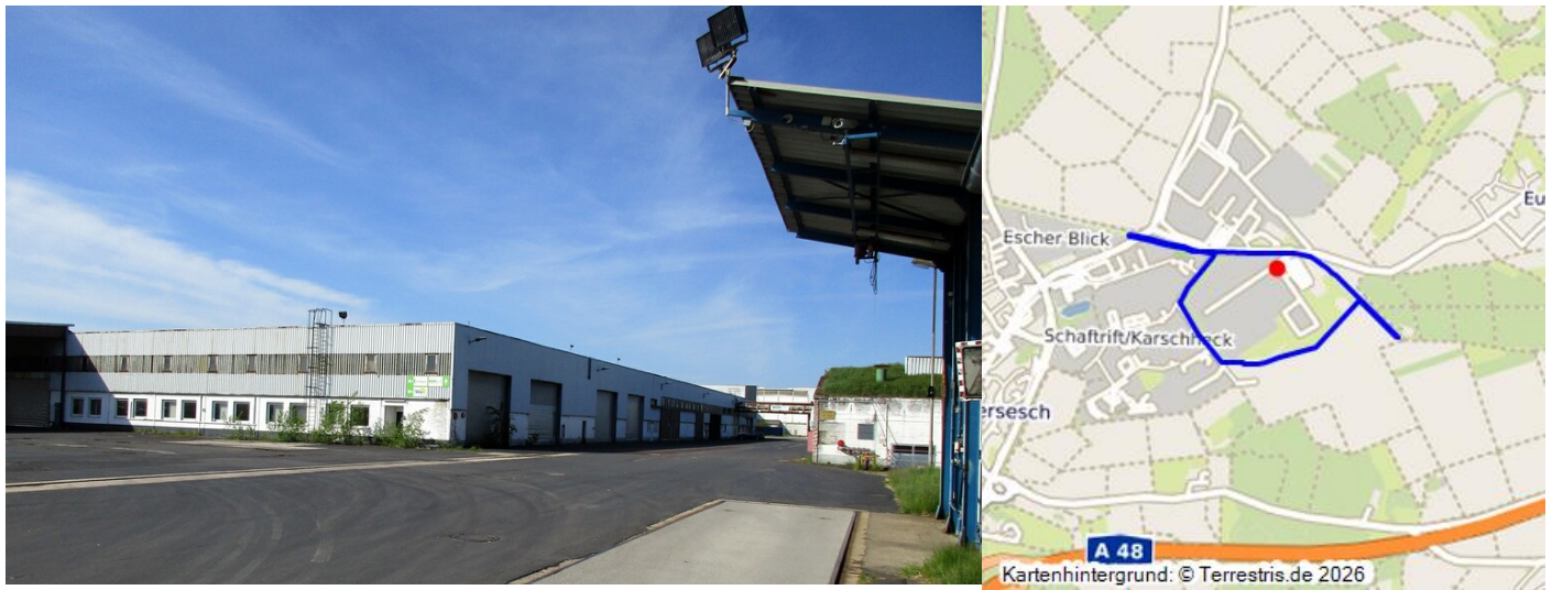
Gebäude der früheren Spanplattenfabrik in Kaisersesch (2023). Fotograf/Urheber: Franz-Josef Knöchel
